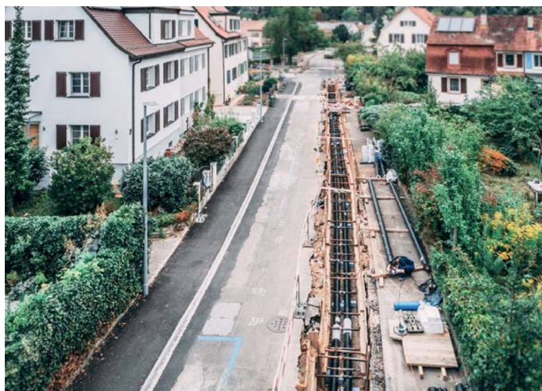
VERLEGUNG DER FERNWÄRMELEITUNG IN RIEHEN
